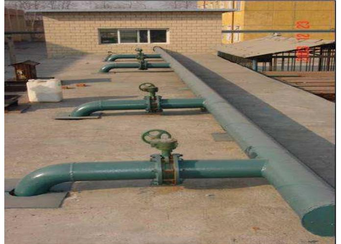
5、高级氧化催化反应器出水送入各台循环水泵入
