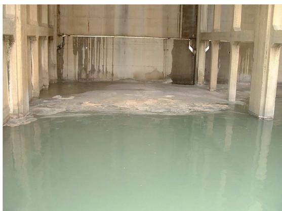
5月21日，水色混白，浊度63度，COD值220 mg/l，停开的塔池中浮沫围着油。
