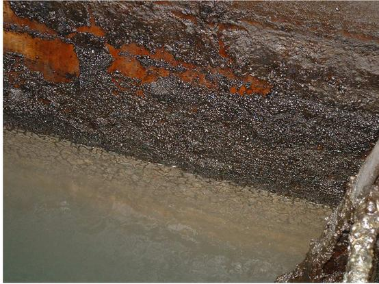
8月13日，热水池壁油层已脱落，只有冷水池壁还未脱落干净，但可观察到表面油层被作用后龟裂的状态。
